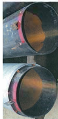
写真-1 井戸管 鋼管φ=500mm、スクリーンφ=550mm、L=6.0m (国土交通省東北地方整備局郡山国道事務所発注、塩川地区下部工工事)
