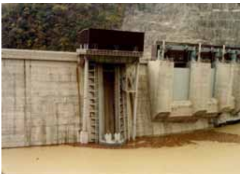
C ダムの濁水状況
