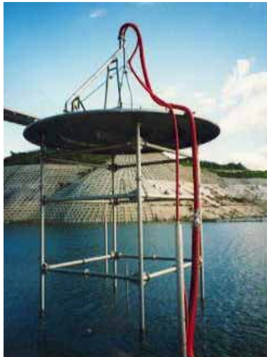
深層曝気施設の外観
